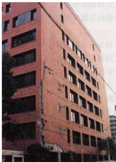
コンクリート壁の表面が剥離・落下している
