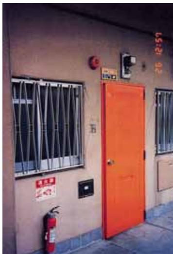
1階の壁のひび割れのために鉄製の玄関ドアが開閉できない
