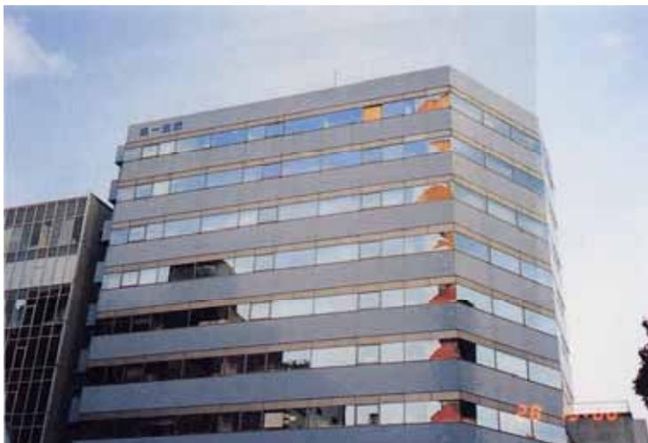
各階の角のガラスが破損している
